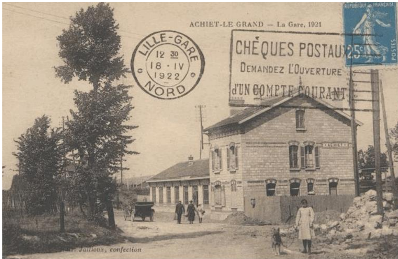
La gare est reconstruite de l'autre côté des voies
